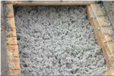
Nichts ist so alt wie die Zeitung von gestern – als Dämmstoff kann sie dennoch gute Dienste leisten. Beim Recycling-Prozess werden aus der morgendlichen Lektüre Zellulose-Flocken, die sich vielfältig zur Wärmedämmung nutzen lassen und dabei anderen Dämmmaterialien in nichts nachstehen.
