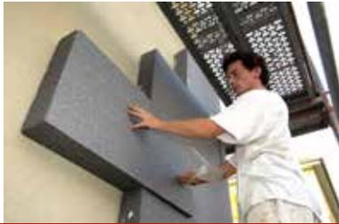
Der Schaumstoff, aus dem Dämmung ist – so könnte die Beschreibung von expandiertem Polystyrol-Hartschaum (EPS) lauten. In der Tat wird der größte Teil der Fassaden mit diesem Material gedämmt. Es ist leicht, preisgünstig und lässt sich gut verarbeiten. Und nicht nur als Dämmung, auch als Verpackungsmaterial ist EPS weithin bekannt. Weit aussergewöhnlicher ist allerdings heute vor allem ein Produktname für expandierten Polystyrol-Hartschaum: Styropor.
